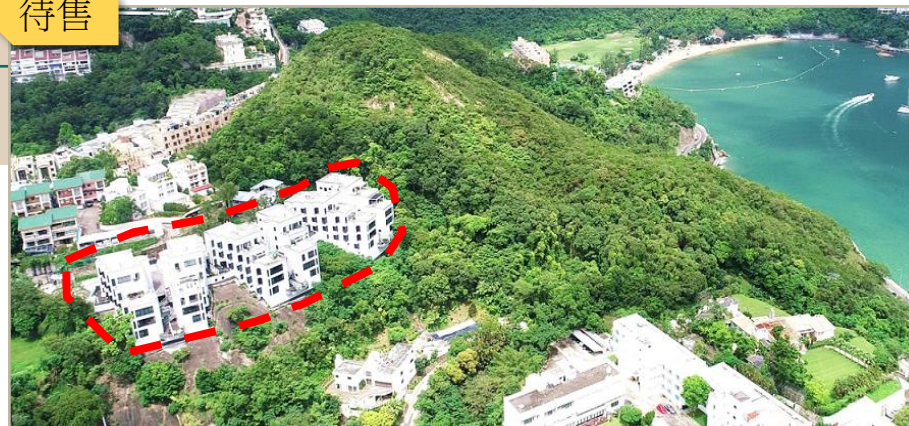
寿山村道重建项目 (兴建中)
