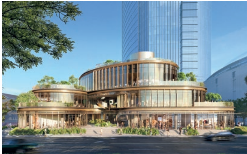
上海恒隆廣場三期擴建項目是內地首個在建築結構中近乎全面採用低碳排放鋼材的商業地產項目
