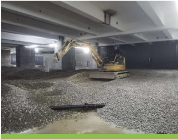
杭州恒隆广场采用再生骨料回填地库
