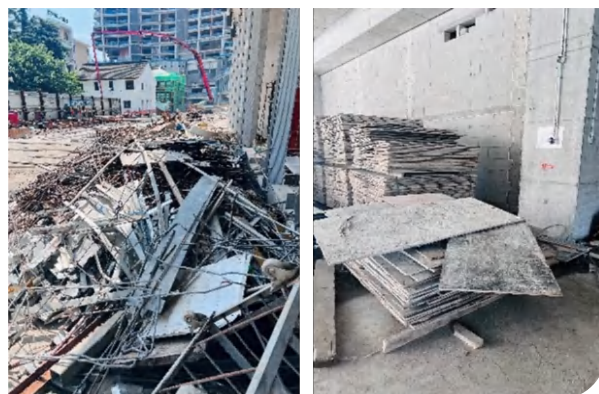
我們在杭州恒隆廣場發展項目的工地的建築廢棄物（鋼鐵、石膏板和木材）現場分揀區域
